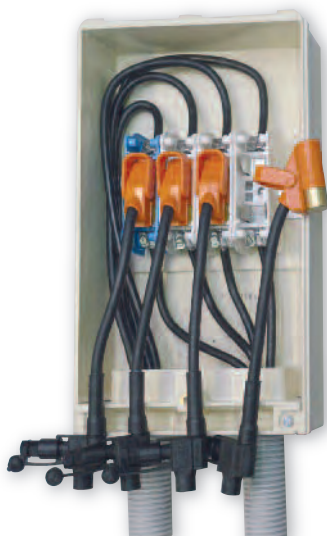
Exemple d'utilisation de 4 dispositifs 22x58 pour un départ triphasé
